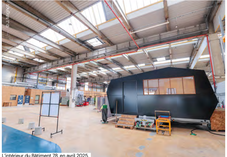
L'intérieur du Bâtiment 78, en avril 2025.
